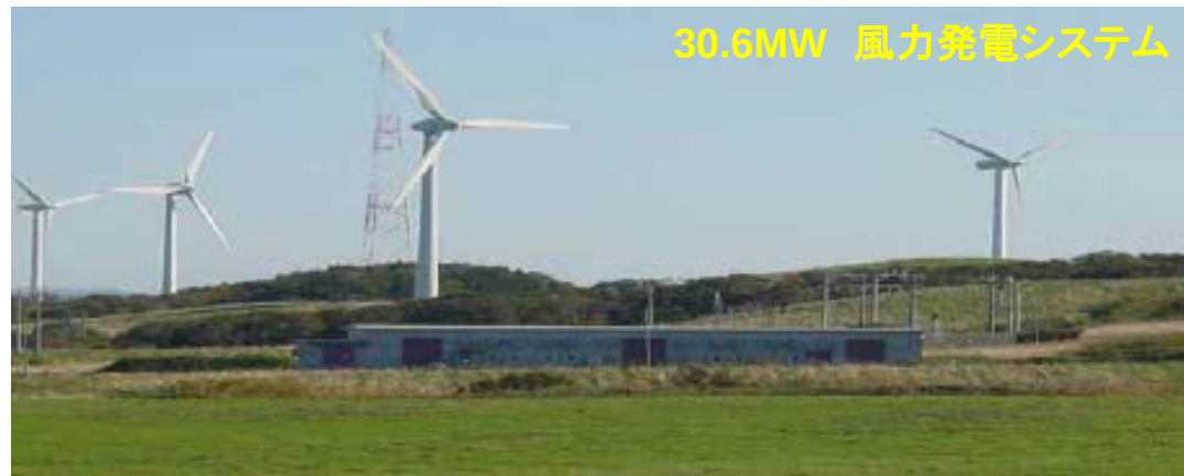
北海道苫前ウインドファーム レドックスフロー電池:6MWh
